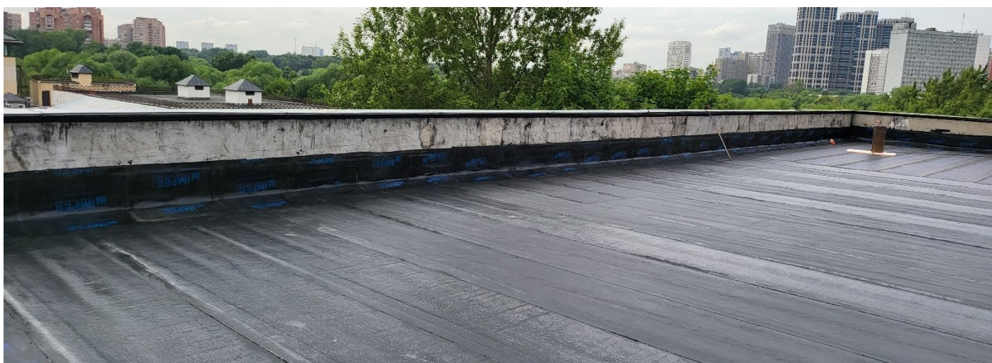
5. Укладка пенополистирола (утеплитель) 50мм в 2 слоя.
